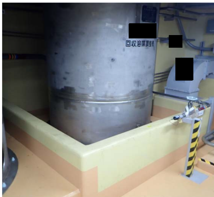
第2図 堰による拡大防止対策例
