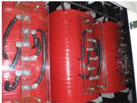
第5図 乾式変圧器
