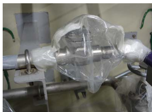
第2図 漏えい化学薬品の飛散防止用の飛散防止カバー等
