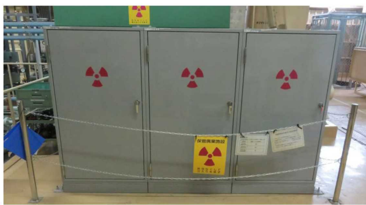
機械棟排風機室の金属製の容器
