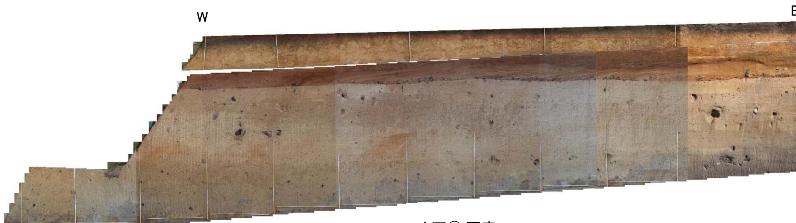
法面② 写真
