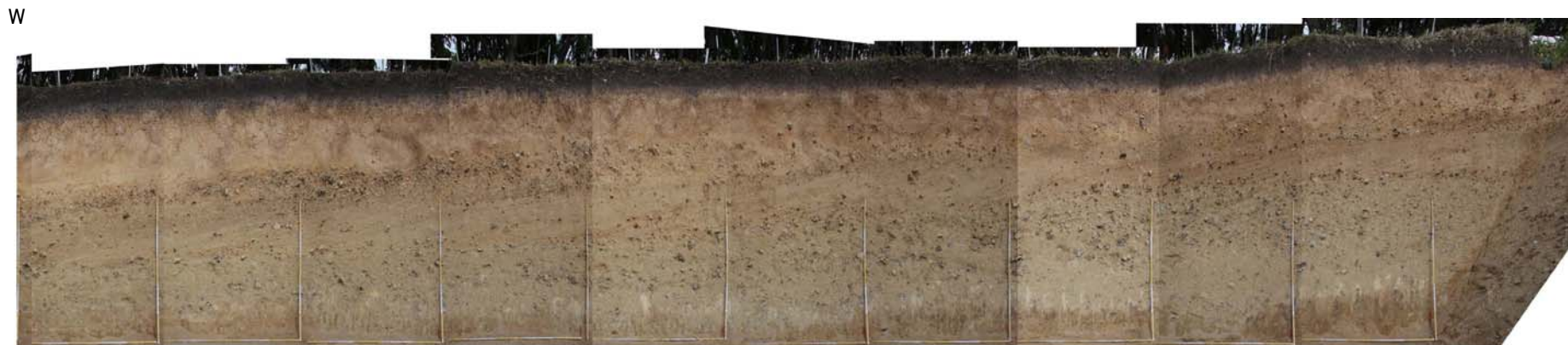
法面③ 写真
