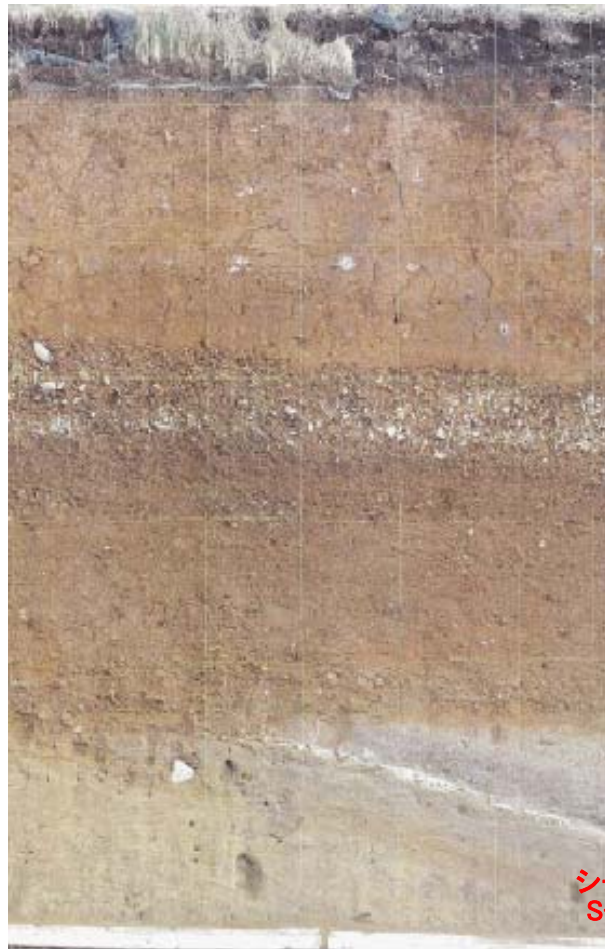
Ts-5法面画像
