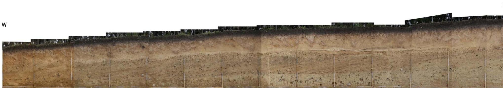
法面④ 写真
