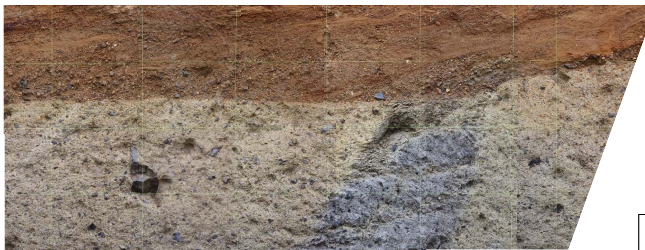
北側法面写真
