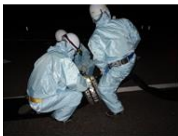
ホース接続作業（夜間）
