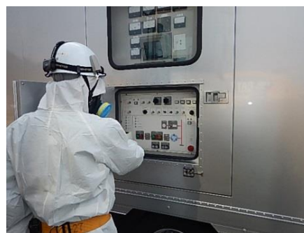
高圧発電機車での作業
