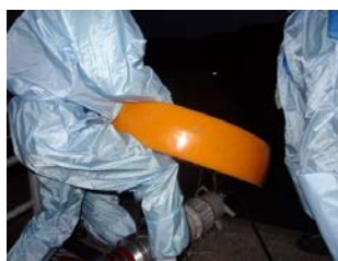
水中ポンプ設置準備（夜間）
