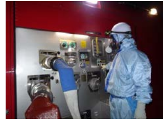
ポンプ起動操作（夜間）
