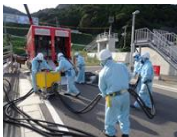
水中ポンプ設置準備（昼間）
