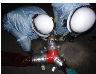
ホース接続作業（夜間）
