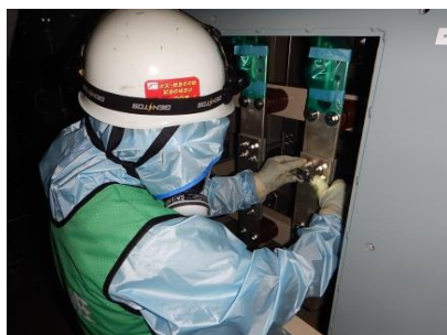
ボルトリンク接続作業
