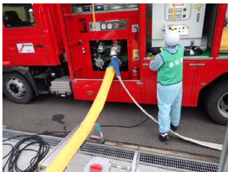
大量送水車起動
