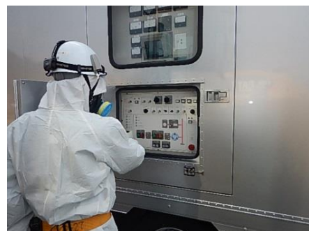
高圧発電機車での作業
