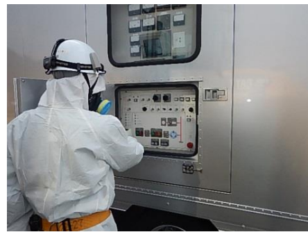
高圧発電機車での作業
