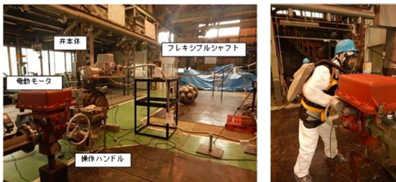
ベント操作（遠隔手動弁操作機構）
