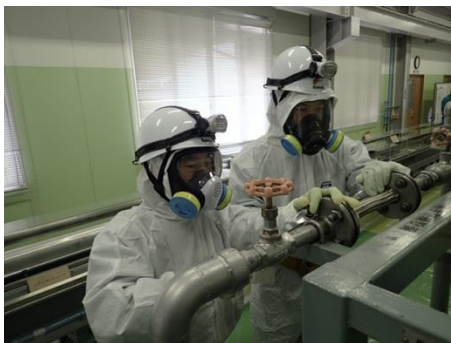
窒素ガス代替供給設備の配管へ短管取付け
