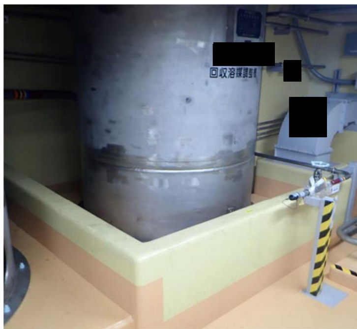
第2図 堰による拡大防止対策例
