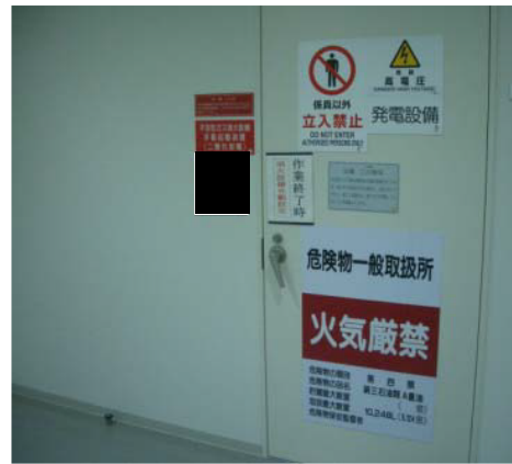
CO 2 設置室入口
