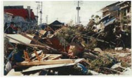
残骸（飛散物）で埋め尽された道路
