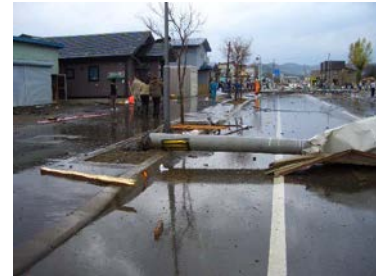
道路側へ倒壊した電柱
