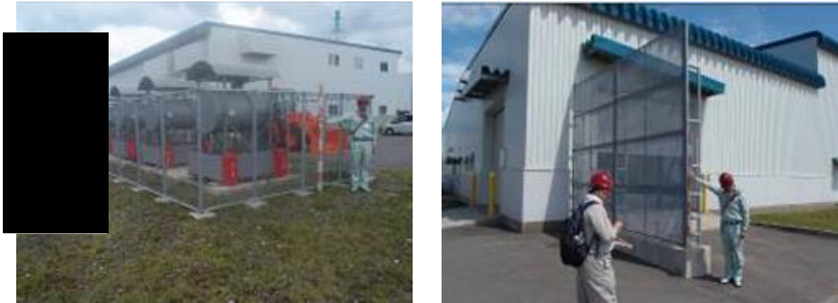
第 32 図 再処理施設におけるフェンスの状況
