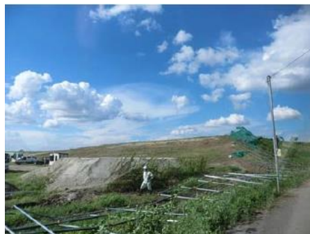
フェンスの倒壊
