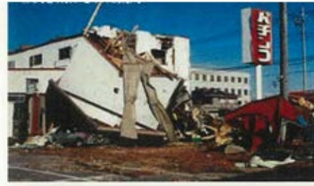
吹き飛ばされた建物
