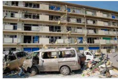
飛来物により被害を受けた住宅等
