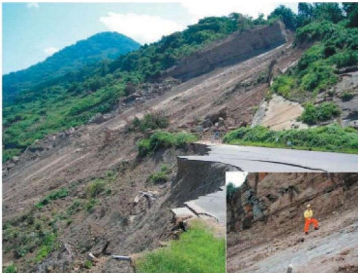
写真1: 流れ盤における崩壊
