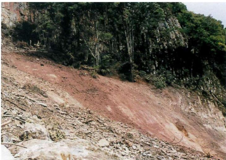
平成12年(2000年)鳥取県西部地震で発生した柱状節理の発達した玄武岩急崖の斜面崩壊
