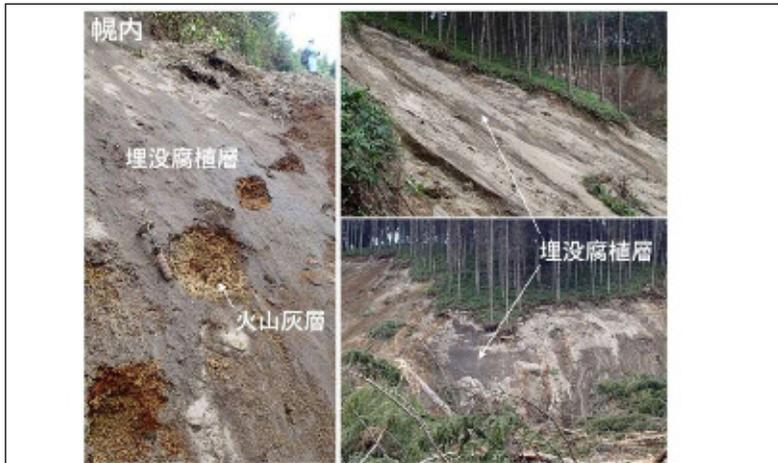
図 4. 斜面崩壊地の滑り面（埋没腐植層型）
