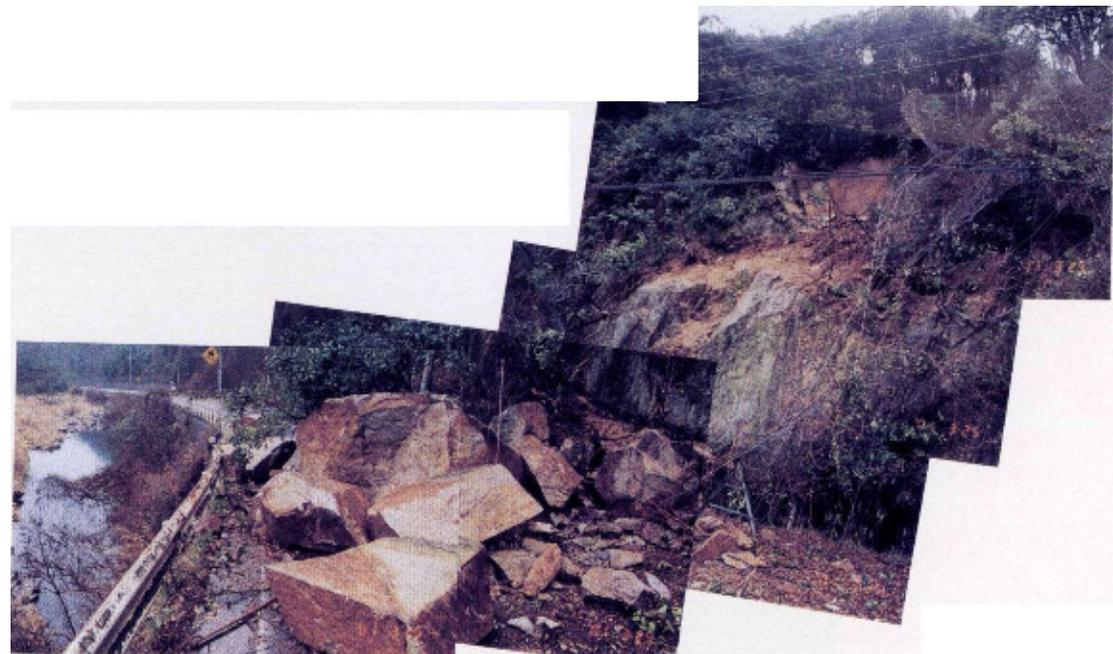
巨石を含んだ花崗岩斜面の崩壊
