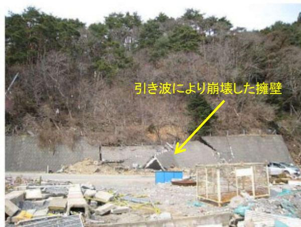
写真2(石巻市雄勝町の斜面崩壊状況)
