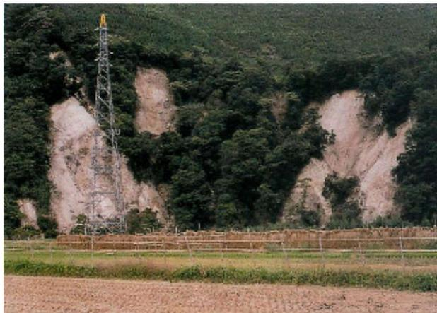
花崗岩急斜面の崩壊
