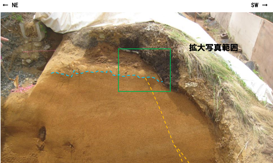
開削調査箇所(南側)南側壁面 小断層上端付近 拡大写真(解釈線あり)
