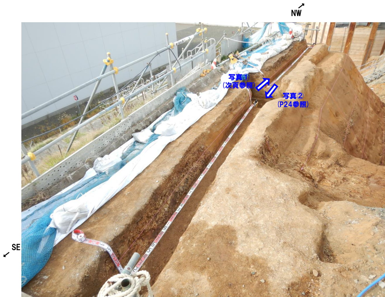
開削調査箇所(南側) 追加人力掘削調査 写真(天端南側から北側を望む)
