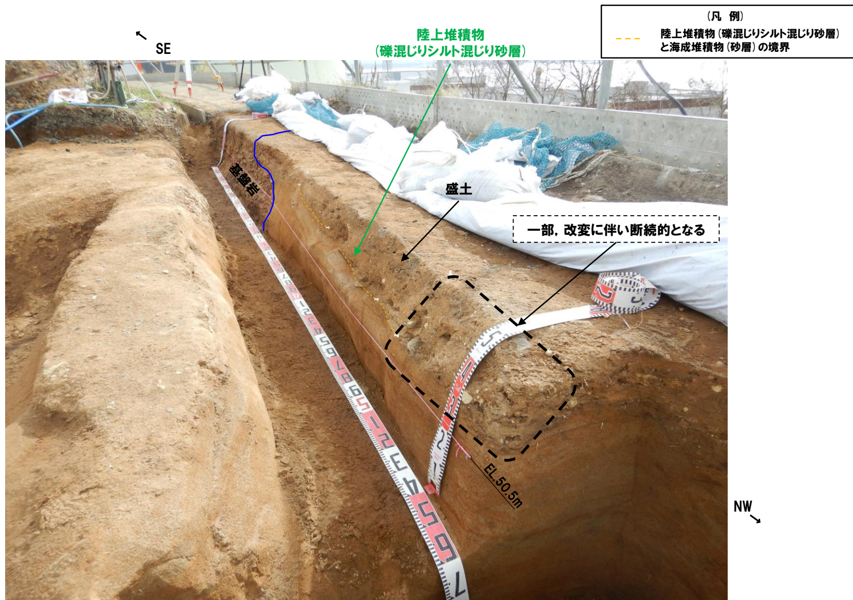
開削調査箇所(南側) 追加人力掘削調査 写真②(解釈線あり)
