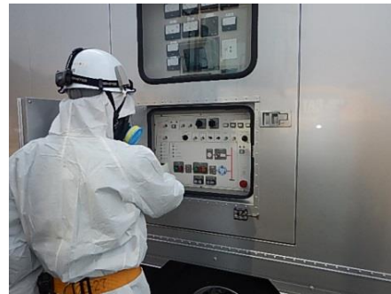
高圧発電機車での作業
