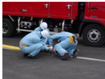
ホース接続作業（昼間）
