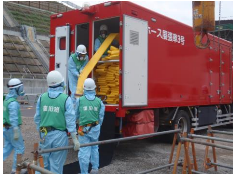
ホース接続を接続口まで敷設
