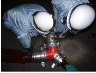
ホース接続作業（夜間）
