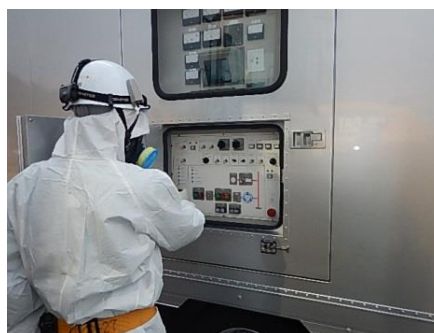
高圧発電機車での作業
