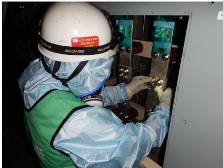
ボルトリンク接続作業
