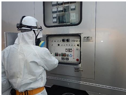
高圧発電機車での作業
