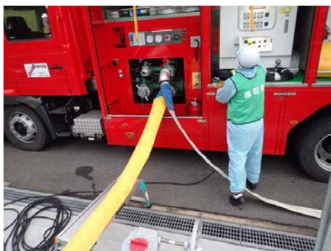
大量送水車起動
