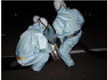
ホース接続作業 (夜間)
