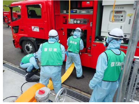
大量送水車へホース接続
