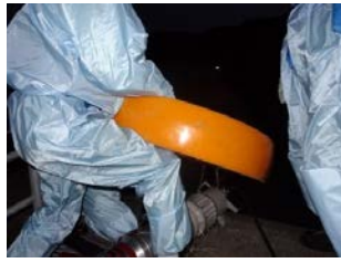
水中ポンプ設置準備（夜間）
