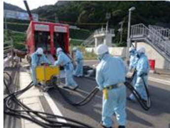
水中ポンプ設置準備 (昼間)
