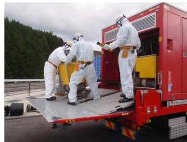
水中ポンプ設置準備
