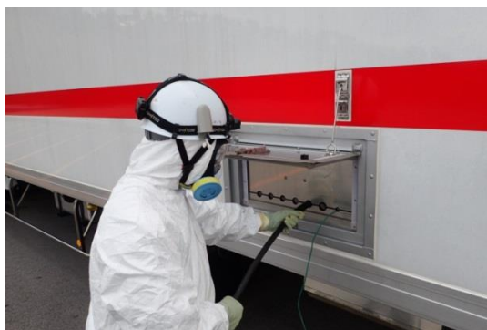
ケーブル接続作業
