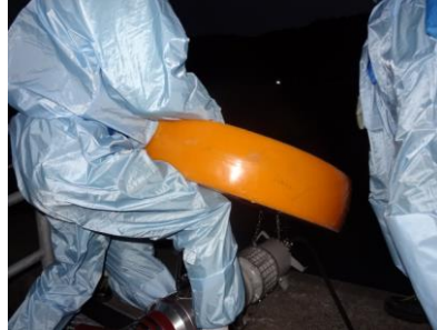
水中ポンプ設置準備 (夜間)
