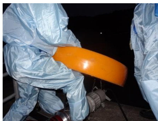
水中ポンプ設置準備（夜間）
