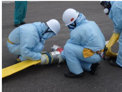
ホース接続作業 (昼間)
