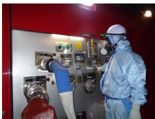
ポンプ起動操作（夜間）
