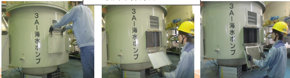
取外し作業イメージ
