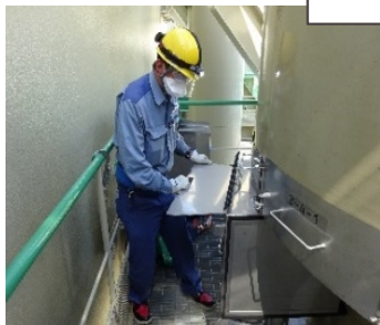
閉止板取付作業
