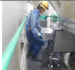
フィルタ抜取作業
