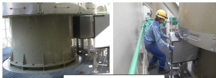
取付作業イメージ
