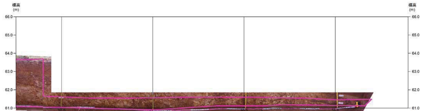
トレンチ壁面写真(A-2拡幅部)(範囲B)
