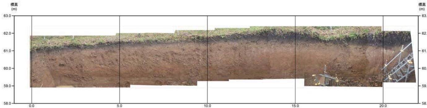
トレンチ壁面写真(C-3)
