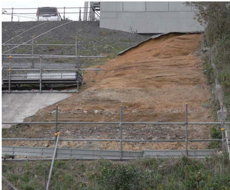
露頭拡幅部全景 (地層境界線なし)
