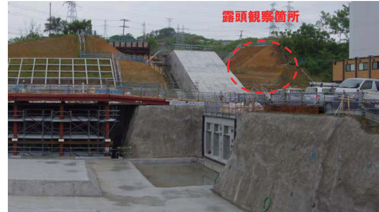
露頭全景 (平成26年)
