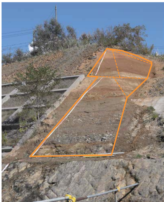
露頭状況写真
