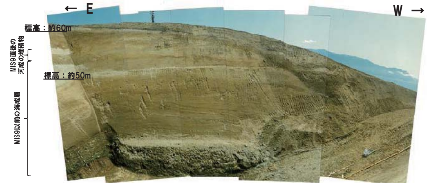
写真2 南側壁面を望む (昭和57年秋頃撮影)
