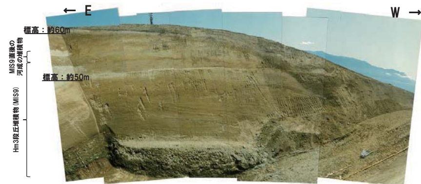
写真2 南側壁面を望む (昭和57年秋頃撮影)
