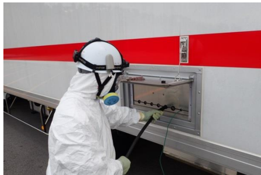
ケーブル接続作業
