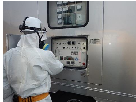
高圧発電機車での作業
