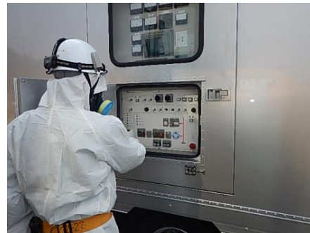
高圧発電機車での作業
