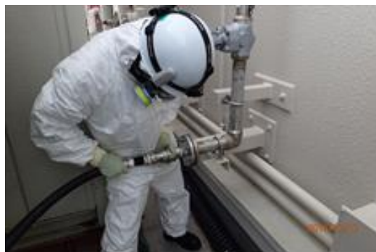
ホース接続作業
