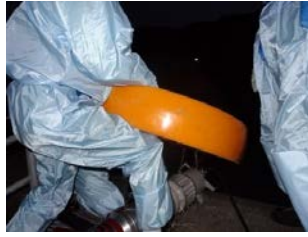
水中ポンプ設置準備（夜間）
