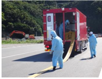
ホース展張作業（昼間）
