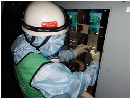
ボルトリンク接続作業
