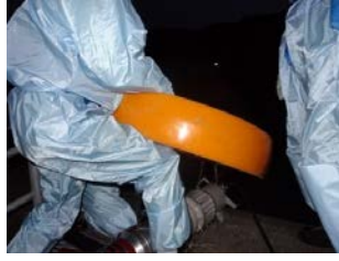
水中ポンプ設置準備（夜間）
