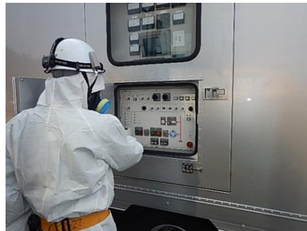
高圧発電機車での作業
