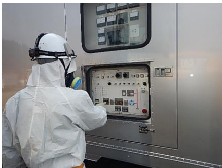
高圧発電機車での作業
