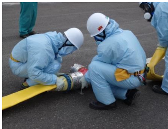
ホース接続作業（昼間）
