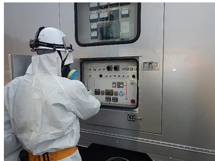
高圧発電機車での作業
