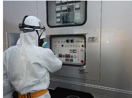
高圧発電機車での作業
