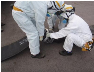
ホース接続作業
