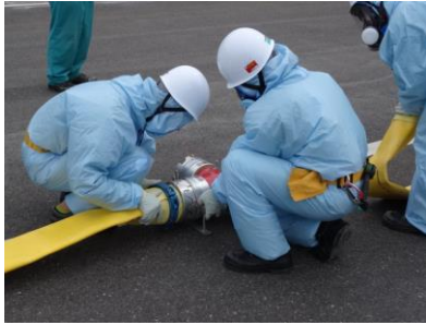
ホース接続作業 (昼間)
