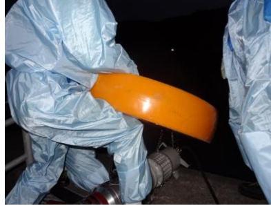
水中ポンプ設置準備 (夜間)
