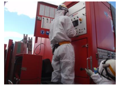
ポンプ起動操作
