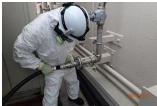
ホース接続作業
