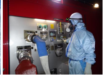
ポンプ起動操作 (夜間)
