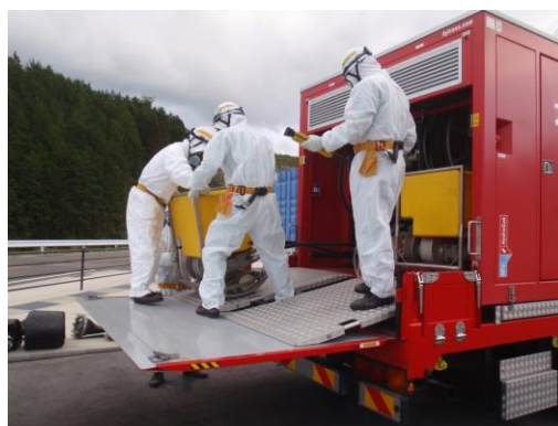
水中ポンプ設置準備
