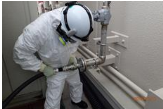
ホース接続作業
