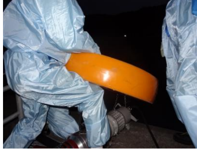
水中ポンプ設置準備 (夜間)
