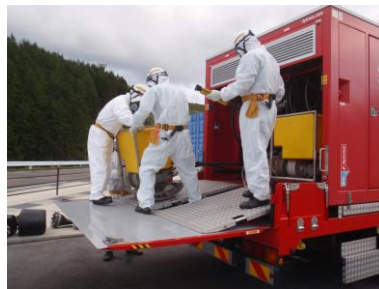
水中ポンプ設置準備
