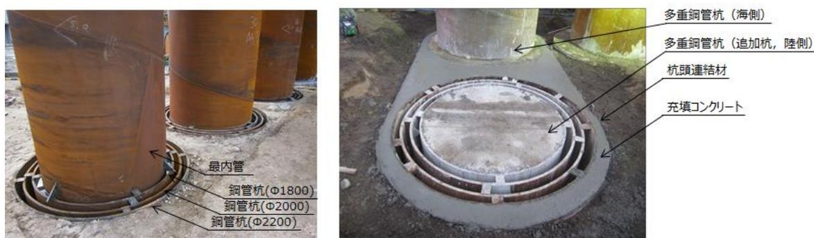
第1-6図 多重鋼管杭建込状況及び杭頭連結材設置状況
