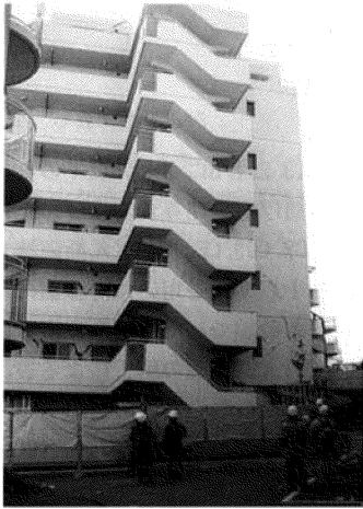
(被災建屋全景)
