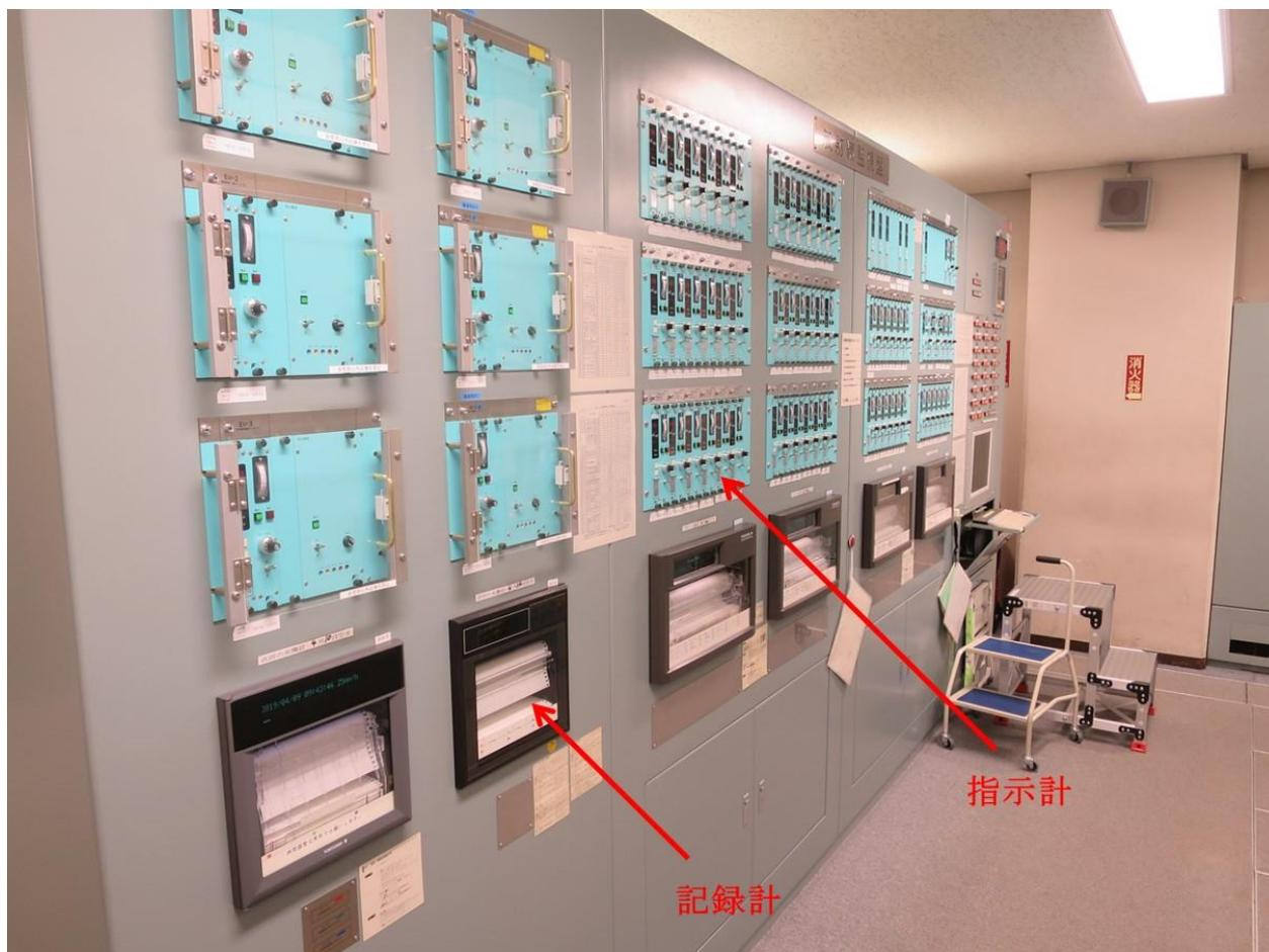
中央制御室の放射線監視盤において、放射線管理に必要なエリアモニタ等の指示又は記録を集中監視できる（下表参照）。
