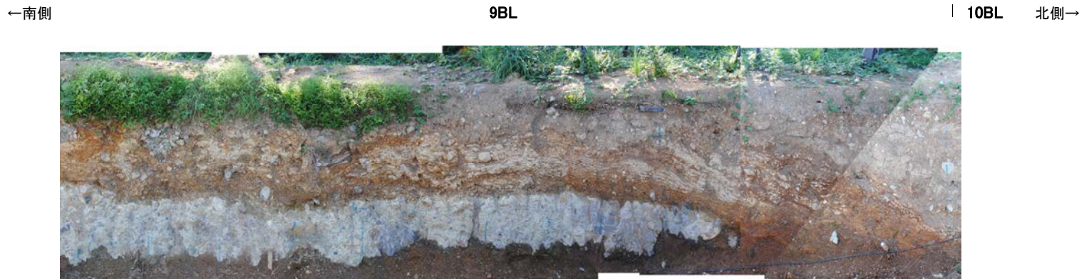
防潮堤設置時写真[9BL, 10BL]①
