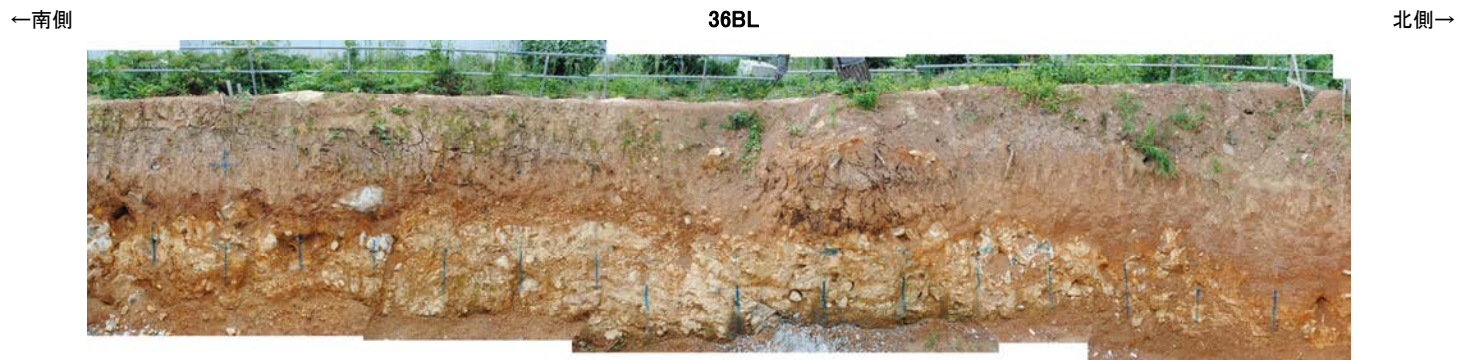
防潮堤設置時写真[36BL]
