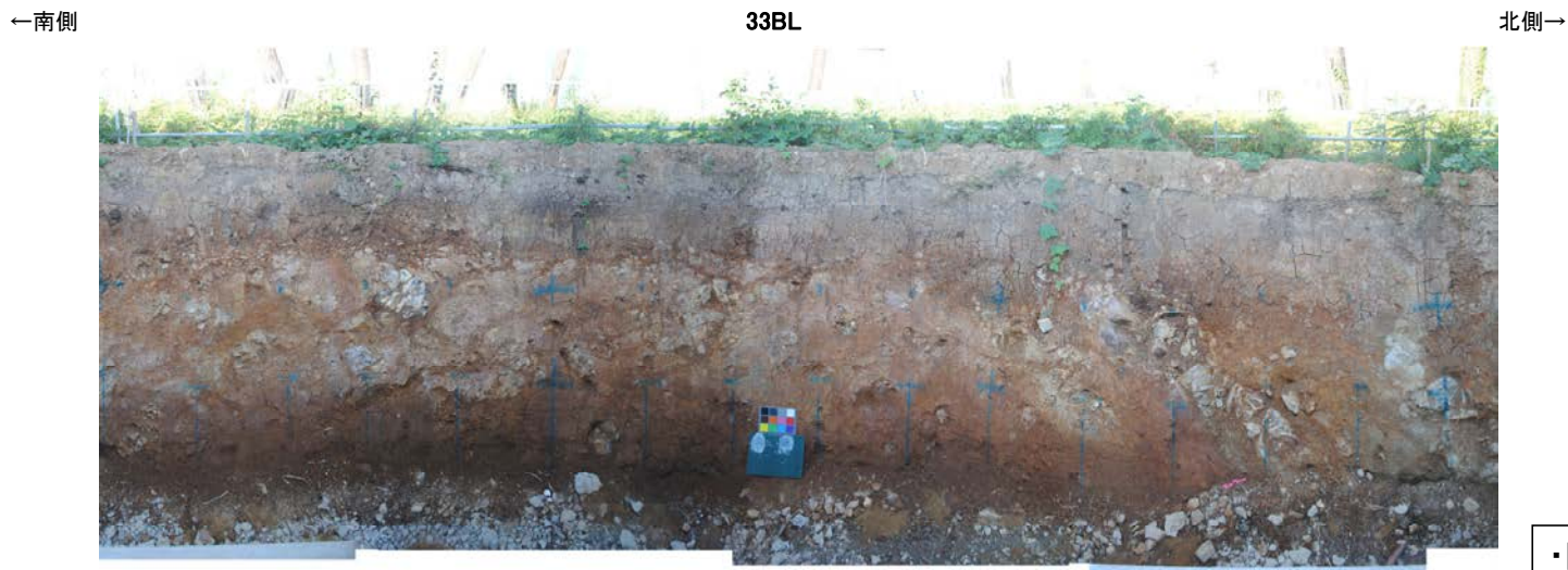
防潮堤設置時写真[33BL]
