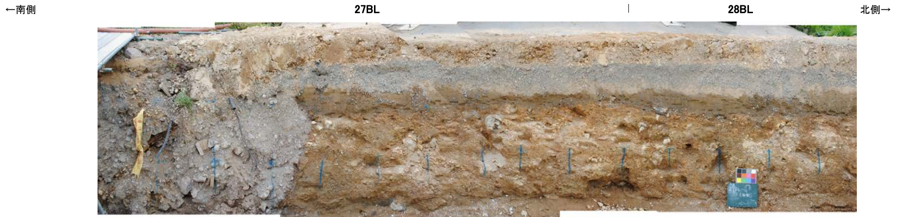
防潮堤設置時写真[27BL, 28BL]①
