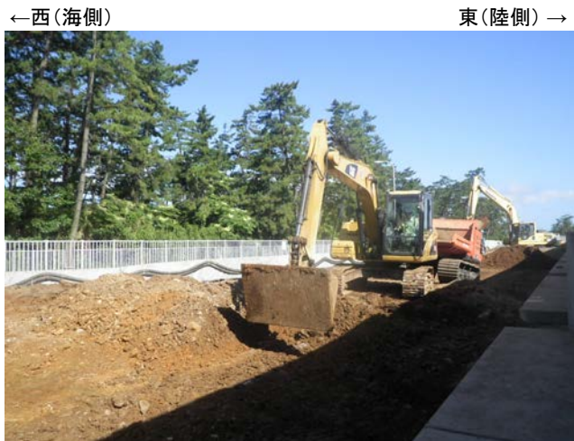
工事状況の写真 (表層部を掘削して地盤改良を行った)
