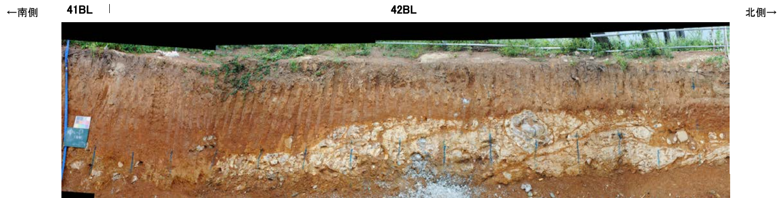
防潮堤設置時写真[41BL, 42BL]②
