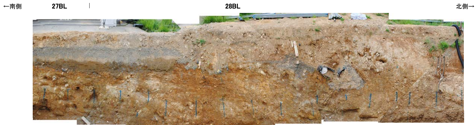
防潮堤設置時写真[27BL, 28BL]②
