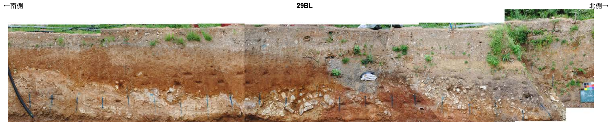
防潮堤設置時写真[29BL]
