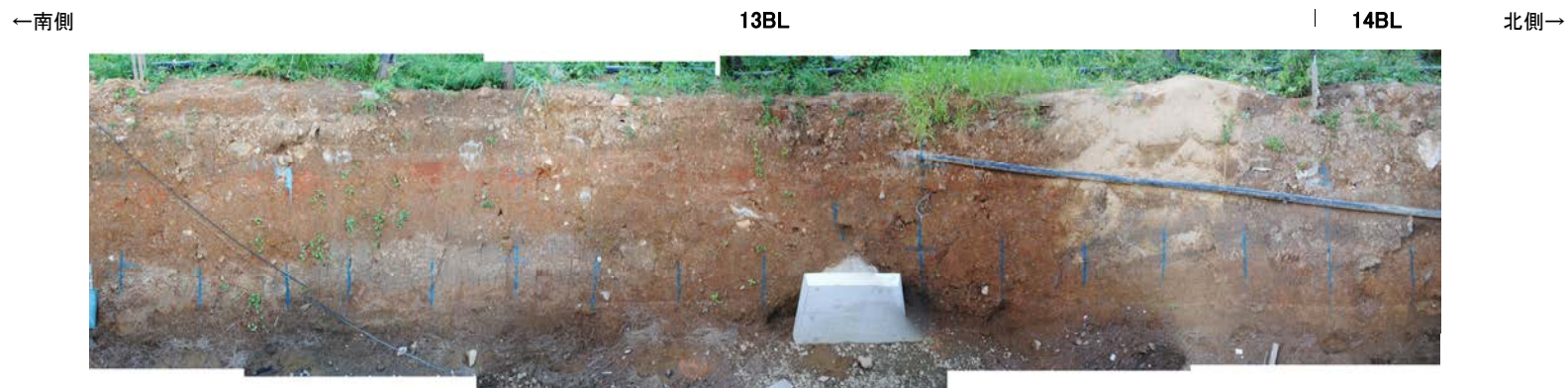
防潮堤設置時写真[13BL, 14BL]①
