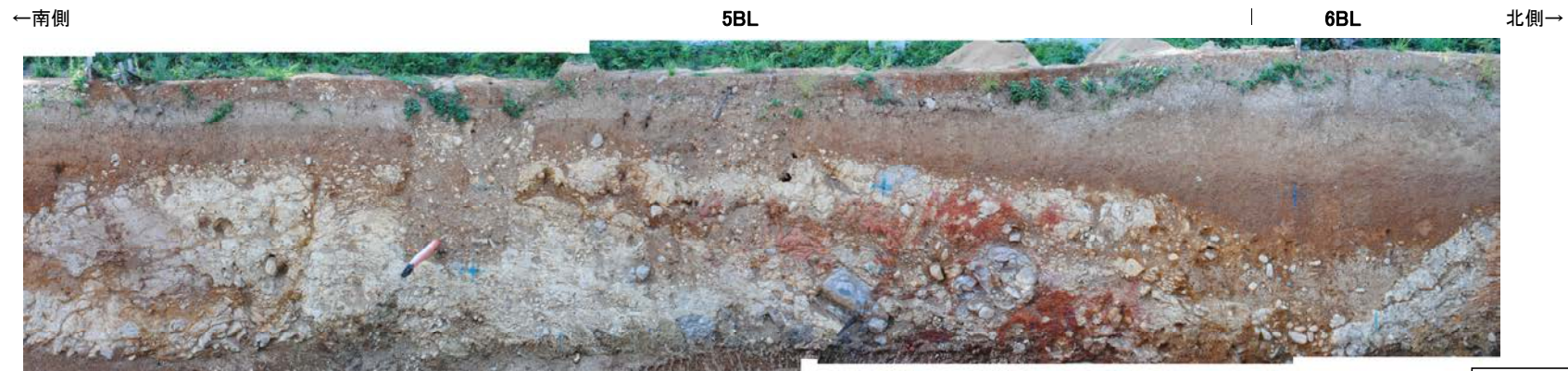
防潮堤設置時写真[5BL, 6BL]①
