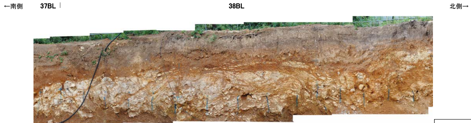
防潮堤設置時写真[37BL, 38BL]②
