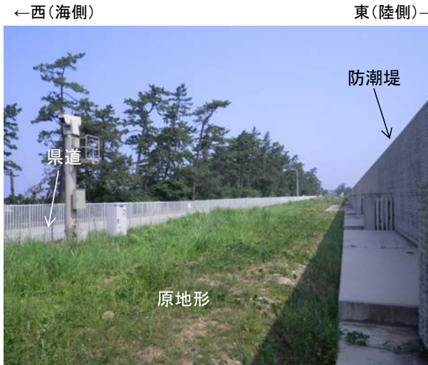
地盤改良工事前の写真 (原地形が残っている)
