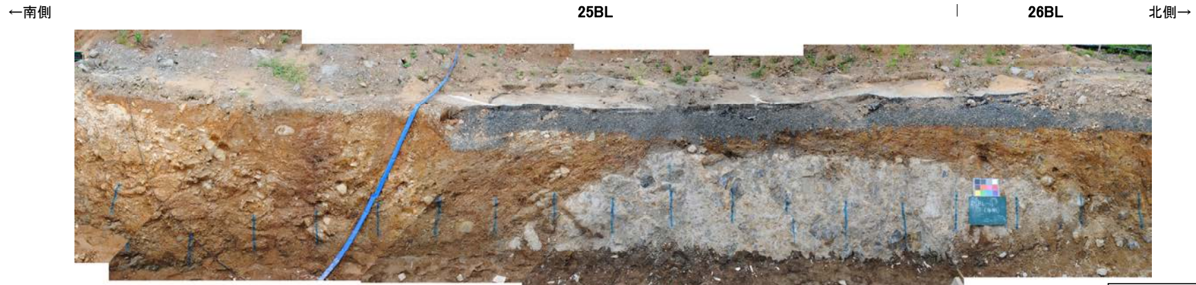
防潮堤設置時写真[25BL, 26BL]①
