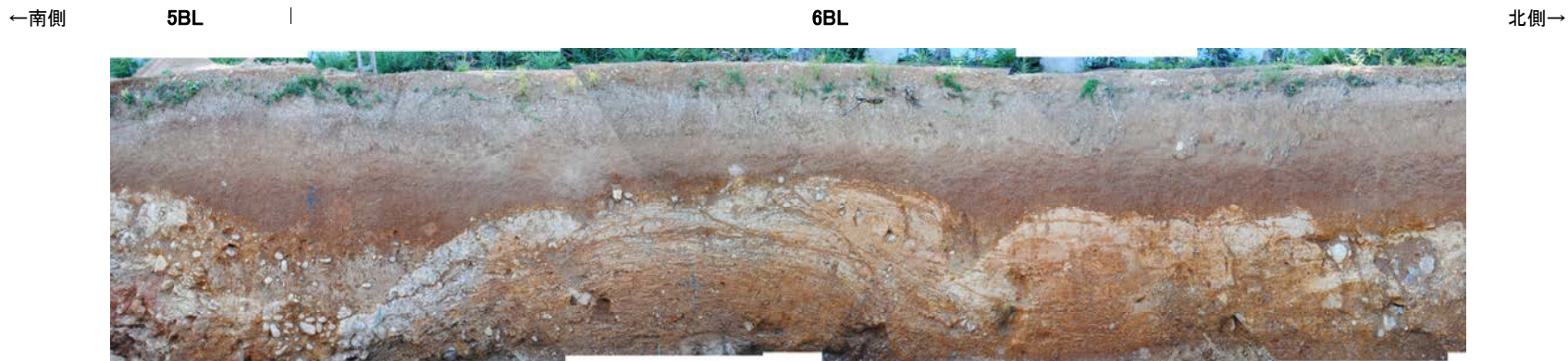
防潮堤設置時写真[5BL, 6BL]②
