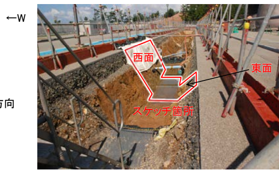
トレンチ全景写真
