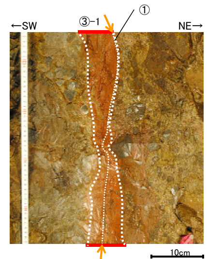
No.7付近底盤写真(破砕部加筆)
