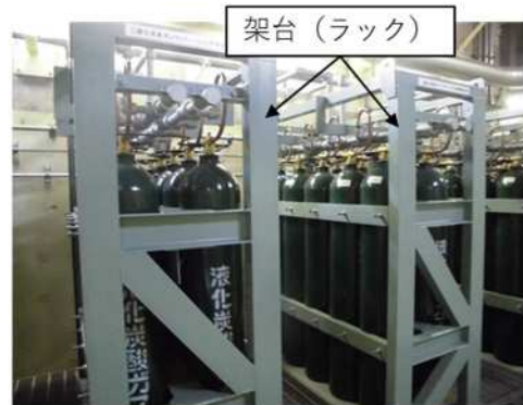
液化炭酸ガス (3号原子炉周辺建屋)
