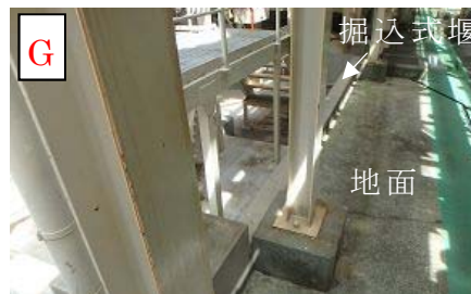
図 5 堰周りの状況 (A - 構内排水処理装置 塩酸貯槽)
