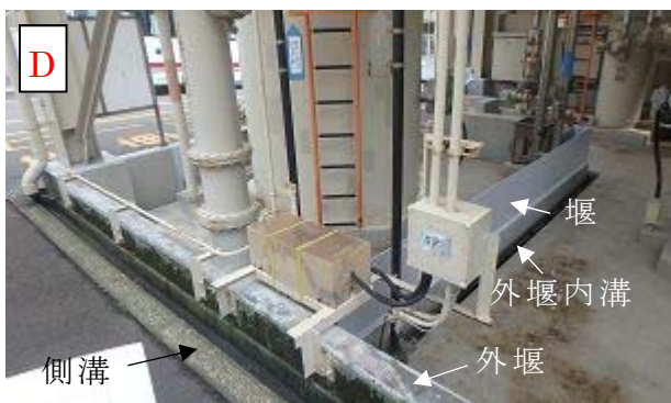
図 6 堰周りの状況 (B-構内排水処理装置 塩酸貯槽)
