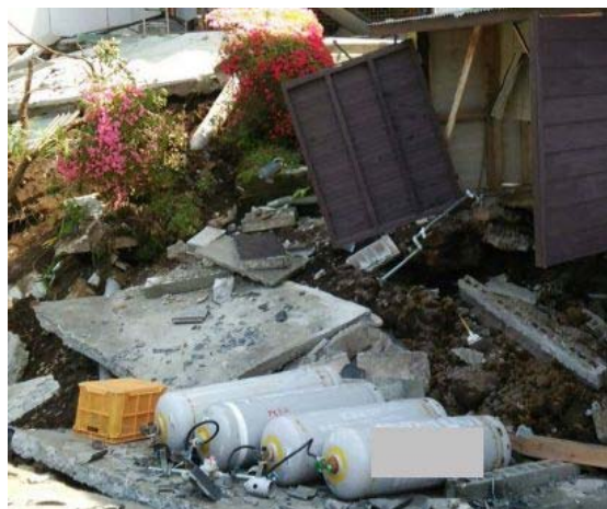
熊本地震での LP ガスボンベの被災状況の一例 3)
