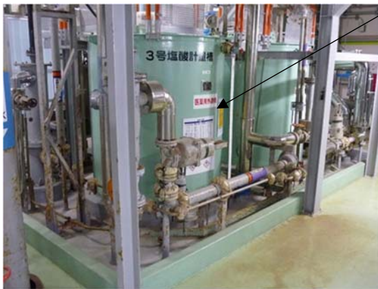
図4 塩酸計量槽設置状況
