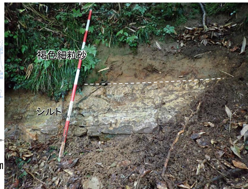
写真a 標高30~35m付近にみられる砂子又層上部層(S 3 ) ・褐色細粒砂とシルトからなる。 ・層相境界は6° 南に傾斜している。
