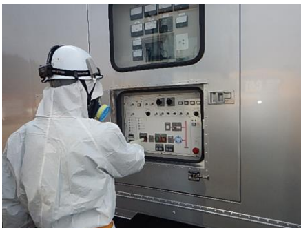
高圧発電機車での作業
