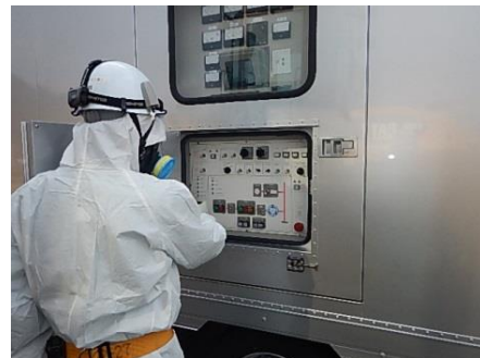
高圧発電機車での作業
