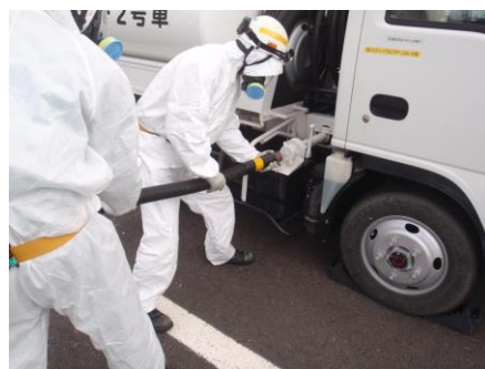
タンクローリへのホース接続
