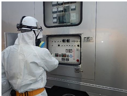
高圧発電機車での作業
