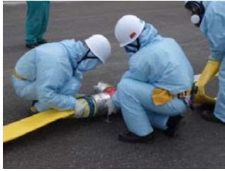
ホース接続作業（昼間）
