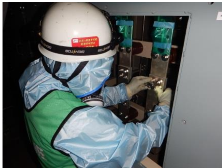
ボルトリンク接続作業
