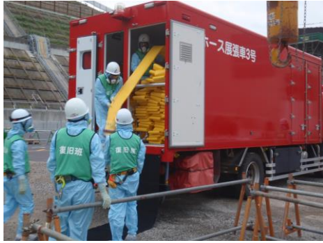
ホース接続を接続口まで敷設
