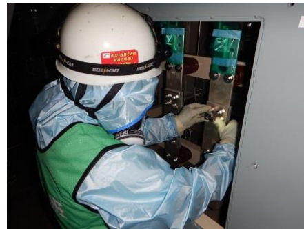
ボルトリンク接続作業
