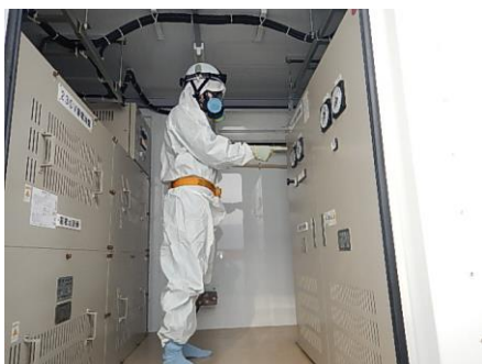
直流給電車での作業
