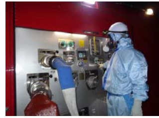
ポンプ起動操作（夜間）
