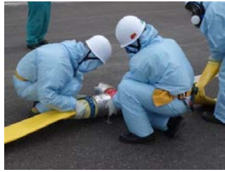
ホース接続作業（昼間）
