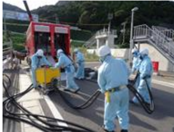
水中ポンプ設置準備 (昼間)
