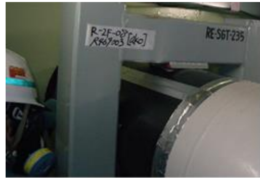
② ゴムシート貼付
