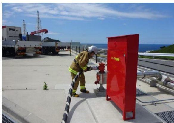
写真1 消火栓接続
