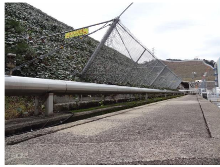
図 1-32 : 屋外消火配管への保温材の設置状況
