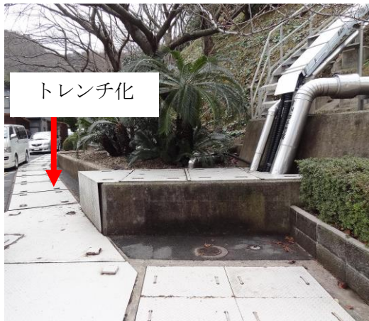
屋外消火配管のトレンチ化
