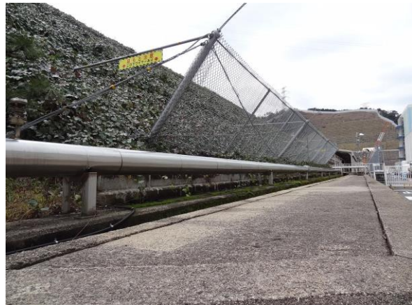
屋外消火配管の地上化
