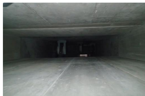
B-給気消音器フィルタ室内
