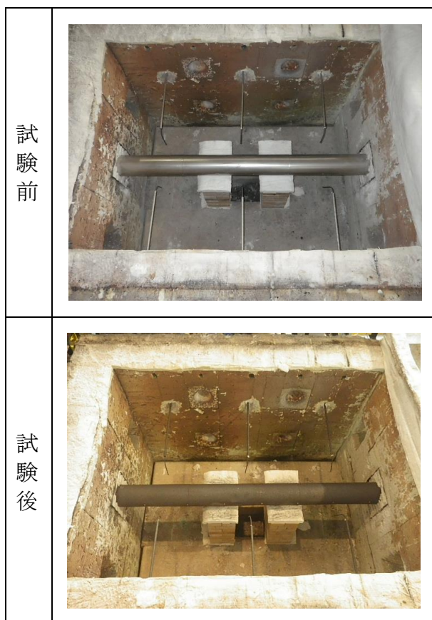
図2：電線管耐火ラッピングの火災耐久試験実施状況
